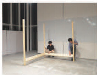
1. 横架材を取り付ける
